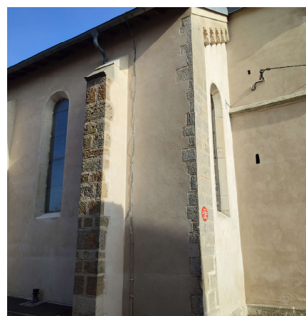
3 – Fil plat du paratonnerre descendant sur le côté de l'église.
